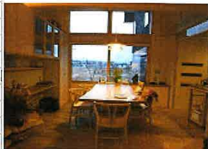
▲北側の眺望窓は、木製の内窓により事実上、トリプル硝子となっていてコールドドラフトを抑えている。二重建具は非常に有効。
