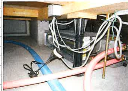
▲1F床下のOMファンコンベクター。 15℃を下回ると自動的に運転が始まる。
