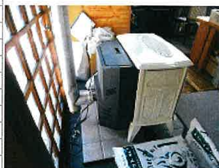
▲背後が開口部のため、排気筒が壁まで長く伸びている
