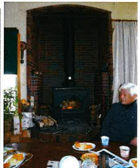
▲ストーブの背後、両側面がレンガ張りになっていて、蓄熱量が十分と見られる。
