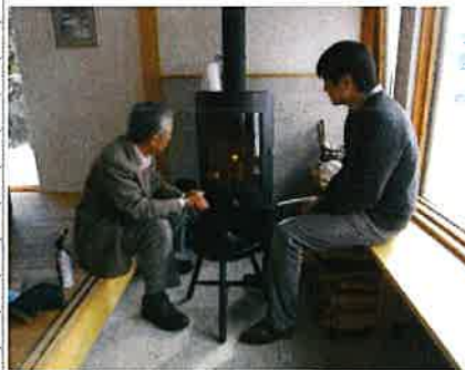
▲背後の壁と土間の床は石張り。 蓄熱効果が高い。 窓際の腰掛の下は、薪置き場。 使いやすく、容量も充分。
