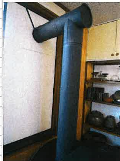
▲既存住宅への設置につき煙突は折れて設置
