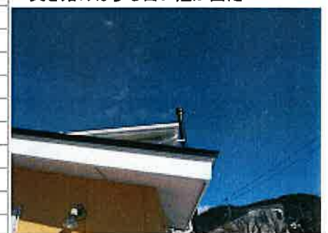
▲背後が開口部のため、排気筒が壁まで ▲風により煙が拡散する
