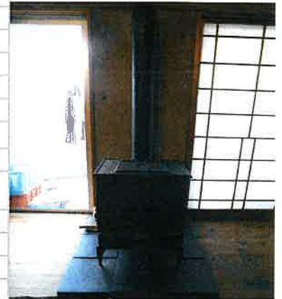
▲ 煙突は一重 煙突は横出しなので煤が溜まりやすく、掃除をまめにしないと煙突が高温になる。
