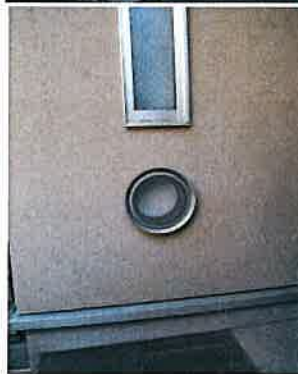
▲ストーブのある居間に設置されている 給気口の外部側。
