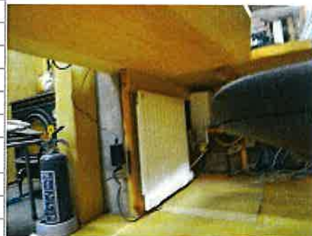
▲事務室の机の下部にはパネルヒーターを設置
