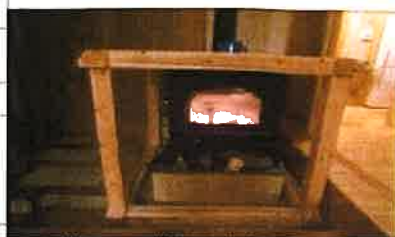
▲冬薪ストーブ利用時は周囲に安全 のためセルフビルドの枠をつけている。
