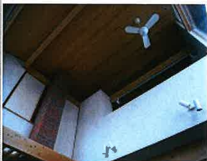
▲順回転・逆回転のできるシーリングファン。 冬場、天井に風を当る回り具合が良い。
