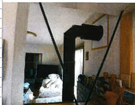
▲壁を貫通する二重煙突部分の納まり
