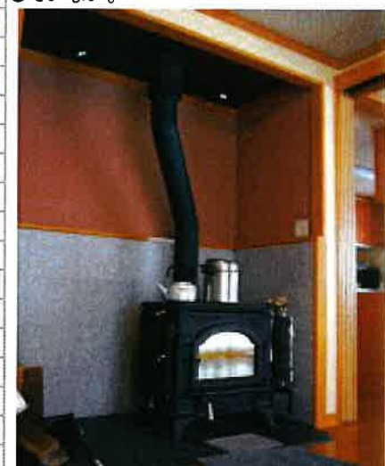
▲居間のストーブ。左側から薪を投入する。
