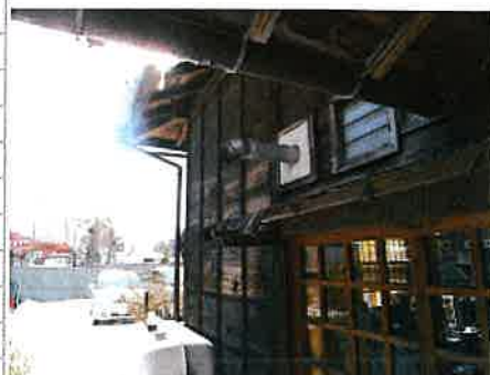
▲外部の軒などを避けて排気筒が外部へ出ている。
