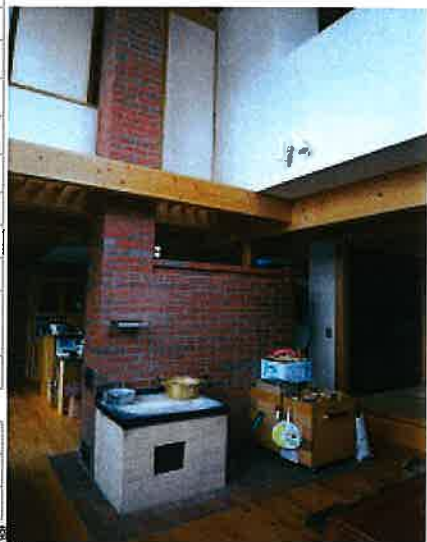
▲家の中心をなすペチカ。ストーブではなく、 建築の一部として造り付けられている。
