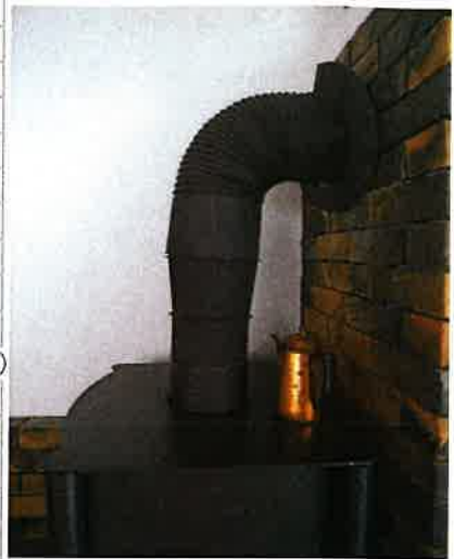
▲短い長さで外壁貫通する煙突。
