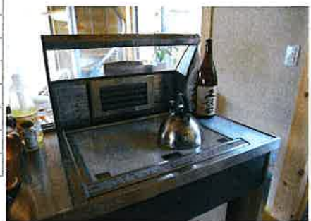
▲ダクトレスのレンジフード。 空気は清浄装置を通して、室内で循環。
