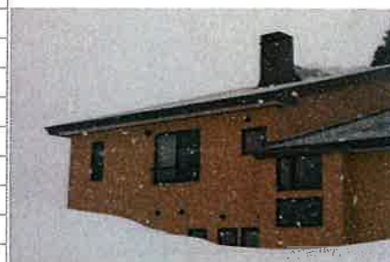
▲煙突(「煙道囲い」)により管が露出してはいない。
