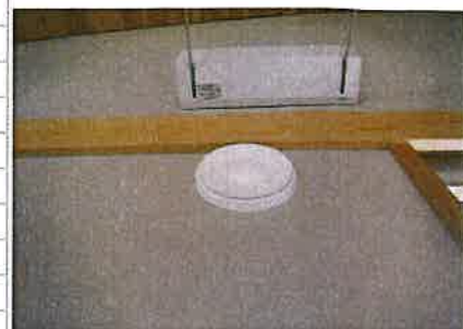
▲ストーブのある居間に設けられた給気口
