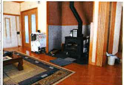
▲煙突が上へ垂直に伸びていないのは ストーブの設置を右にずらせたため とのこと。
