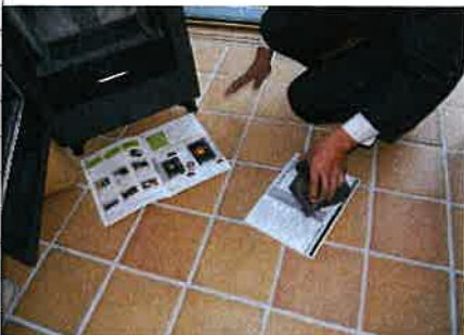
▲タイル敷の土間床に 設置され、床への蓄熱も期待される。
