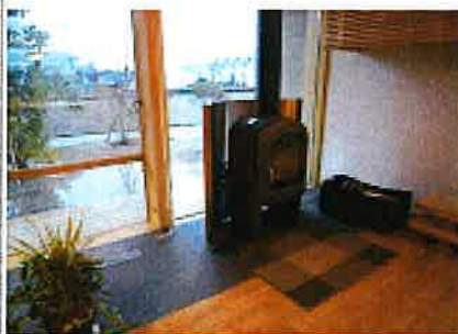
▲ストーブの下の床の窓側部分は 蓄熱床となっている。 ストーブの熱や、日差しによる熱を蓄える。
