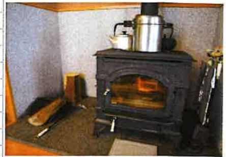
▲左側に余裕のスペースが必要のため (薪の投入は左の扉を使用) 当初予定より、右にずらせて設置。
