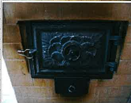
▲空気調節孔のついた薪投入口
