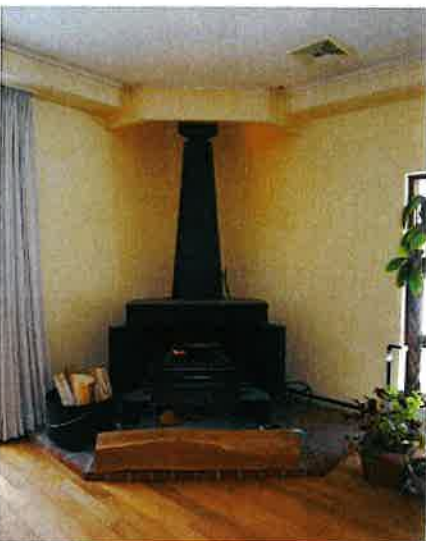
▲レストラン棟の半密閉式ストーブ
