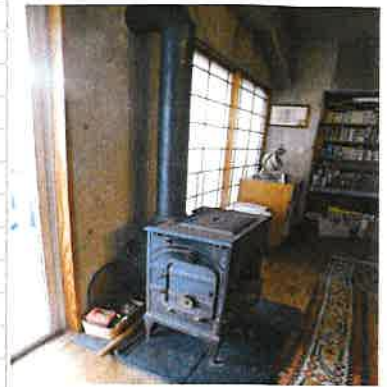
▲ 居間の薪ストーブ 背面壁:コンクリート打ち放し 薪ストーブ床:タイル
