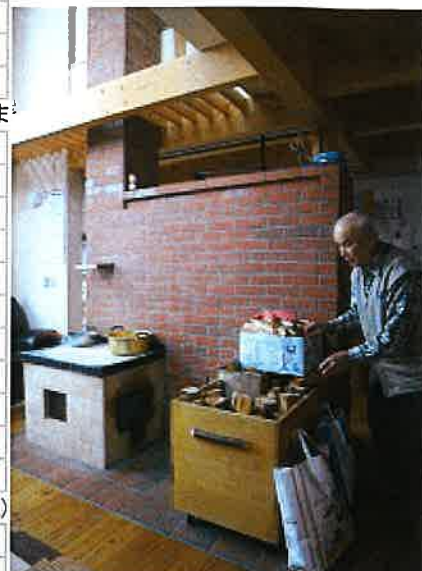
▲日中は、ご両親が適切に管理されている。 背後のレンガ壁の中を煙道が曲がりくねり、 蓄熱壁として有効に働いている。
