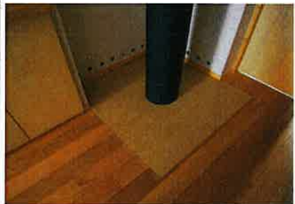
▲煙突の周囲壁を通気壁としている納まり。
